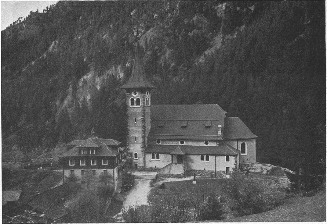
Aufnahmen von E. Hausammann, Heiden.
