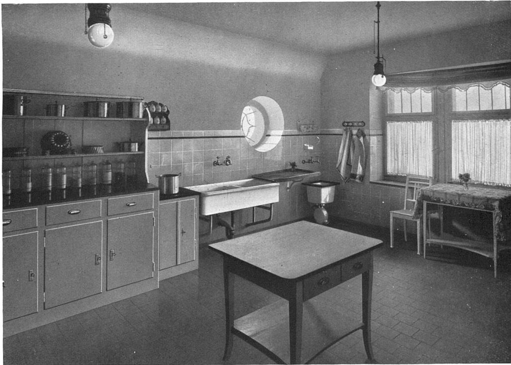
Aus der Küche einer Villa im Rigiquartier zu Zürich. — Architekten Marfort & Merkel, Zürich. Herd für Kohle und Gasbenützung; kombinierbare Warmwasserbereitungsanlage; Feuertön-Spültisch; porzellan-emaillierter Astoria-Ausguss mit Holzrand. Alle Apparate von Bamberger, Leroi & Co., Zürich und Frankfurt a. M. — Installationen von Guggenbuehl & Müller, Zürich. Aufnahmen von A. Wolf-Bender, Zürich.
