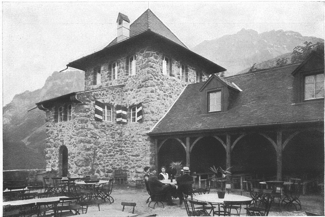
Das «Schlössli» bei Niederurnen. — Architekt Fr. Glor-Knobel, Glarus. Aufnahmen von Photograph Schönwetter-Elmer, Glarus.
