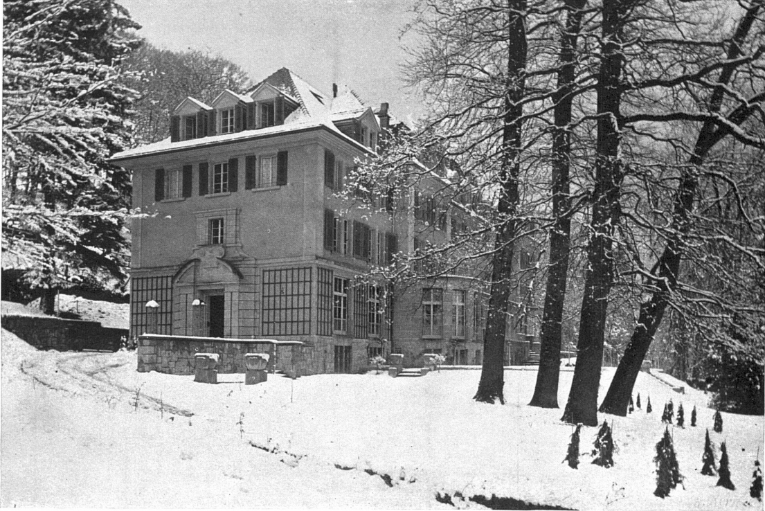
Das Knabeninstitut La Chablière bei Lausanne. — Ansicht von der Zufahrtsstrasse. Architekt Georges Epiteaux, Lausanne. Aufnahme von Phot. A. Kern, Lausanne.
