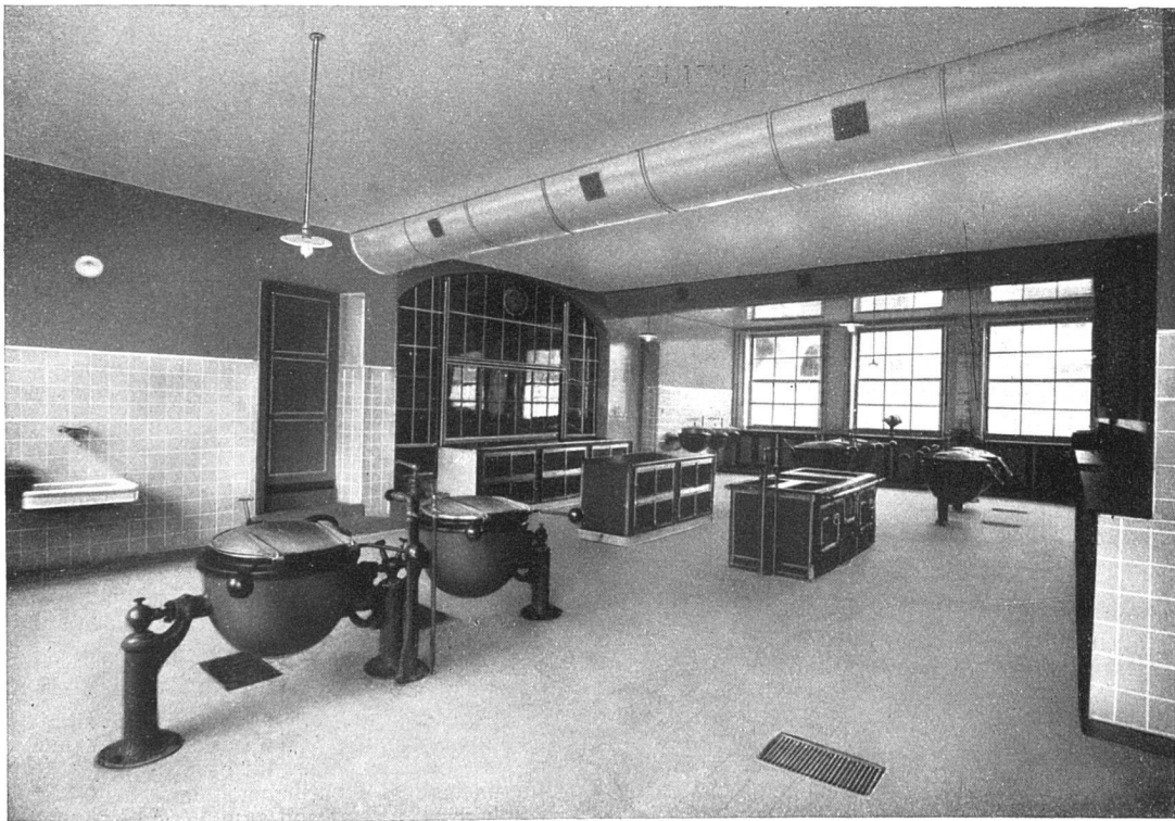
Die Küche der Frauenklinik. — Architekt G. Epitoux, Lausanne.
