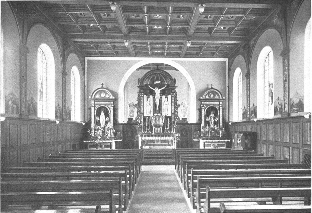
Institut «Stella maris» in Rorschach. — Inneres der Kapelle. Architekt A. Hardegger, St. Gallen.
