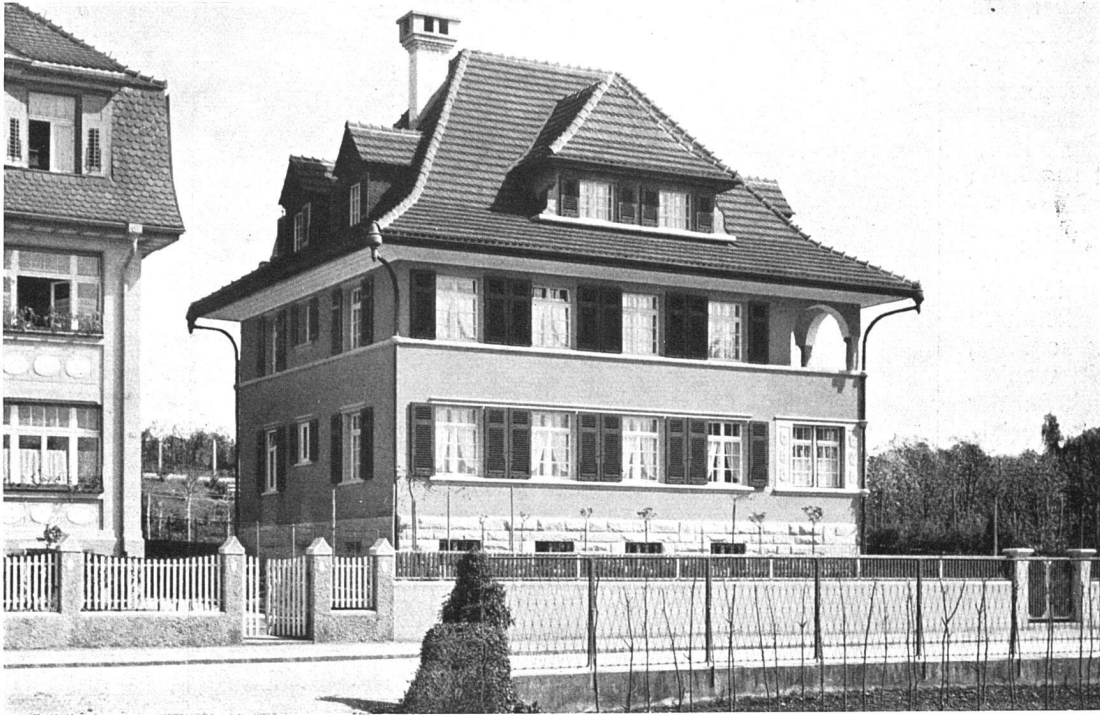
Zum Pfarrhaus umgebaute Villa der Achtzigerjahre in Arbon. Architekt A. Kuhn, Arbon.
