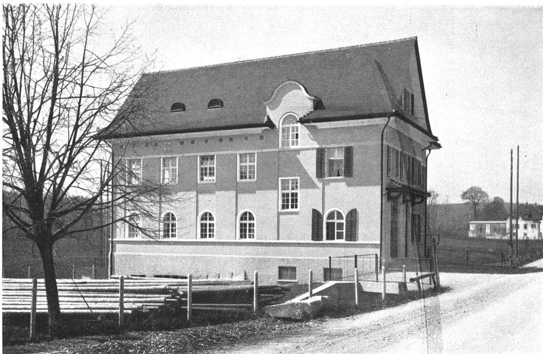
Transformatorengebäude in Arbon. — Westseite. Architekt A. Kuhn, Arbon.
