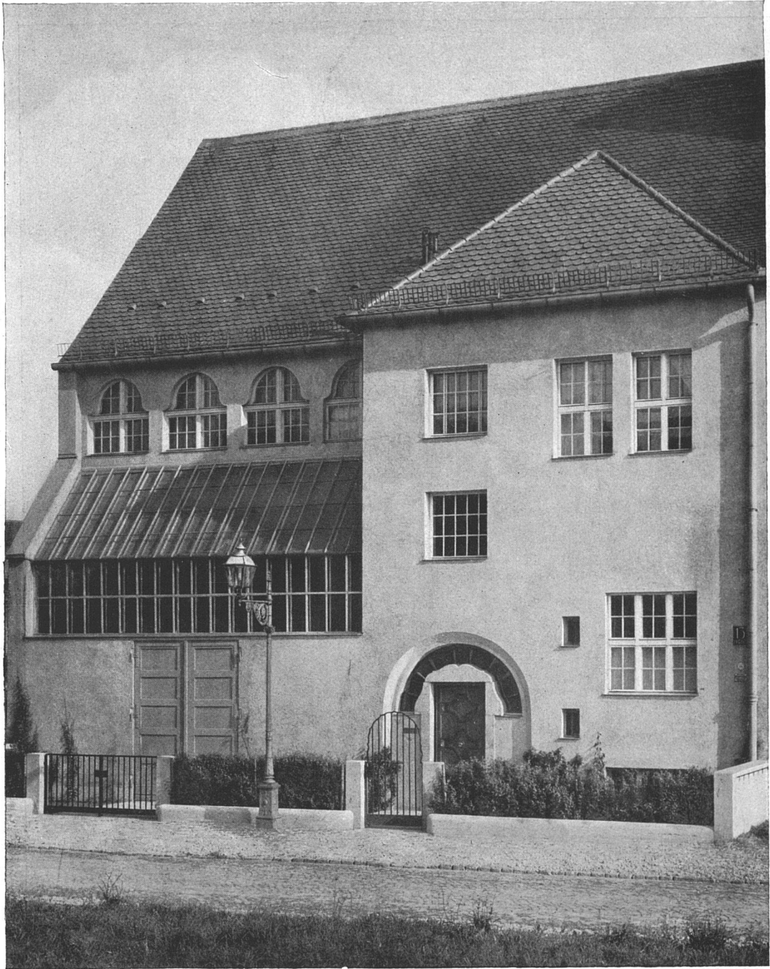
Das Wohnhaus Mitscherlich mit Atelier zu München-Schwabing. Architekt Albert Rieder, Basel-Berlin.
