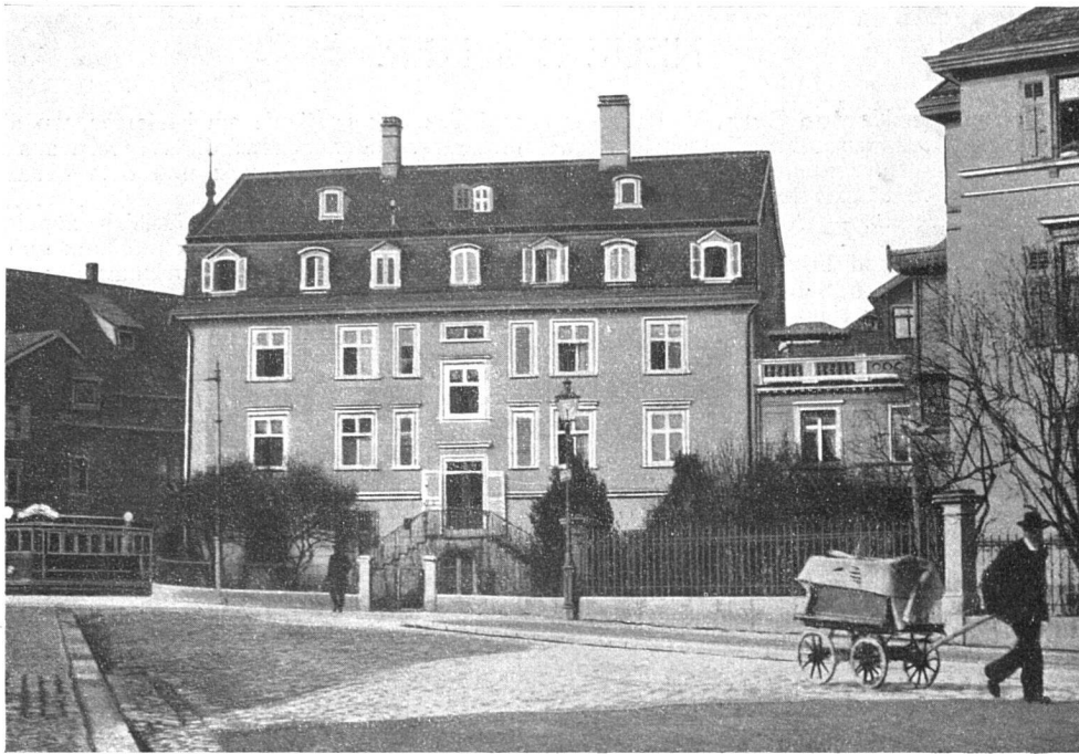
Bankhaus Wegelin & Co., St. Gallen. Der Nothveststein vor dem Umbau.
