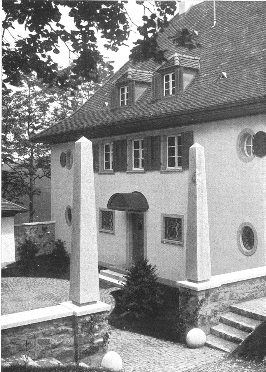
Landhaus Bilsteinfluh ob Waldenburg. — Eingangshof. Architekt: Hans Bernoulli, Basel.
