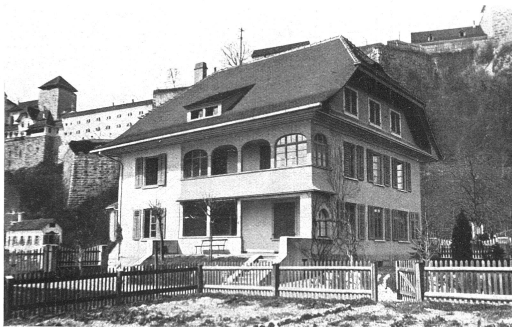
Wohnhaus in Aarburg (Kt. Aargau). — Architekt: Hermann Walliser, Bern.
