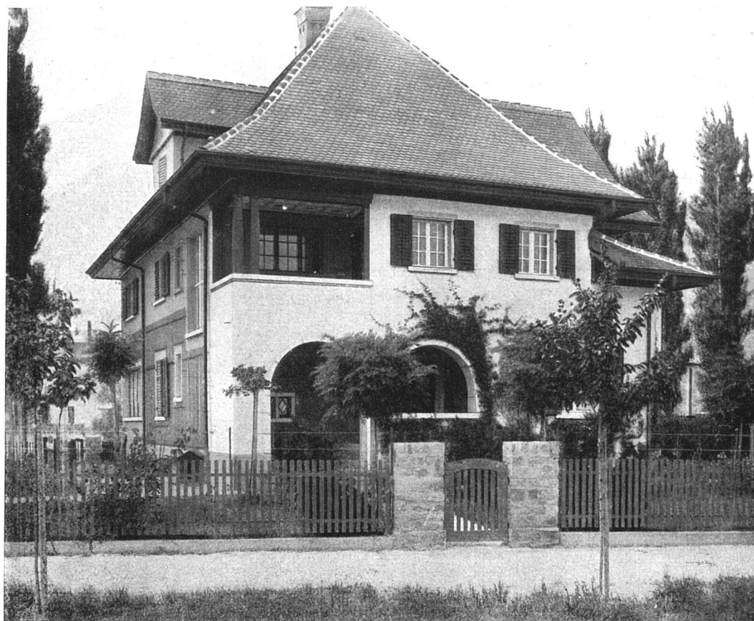
Aluminium-Industrie A.-G. Neuhausen, Filiale in Chippis. — Direktorwohnung (Nordansicht). Architekt: C. Werner, Schaffhausen.
