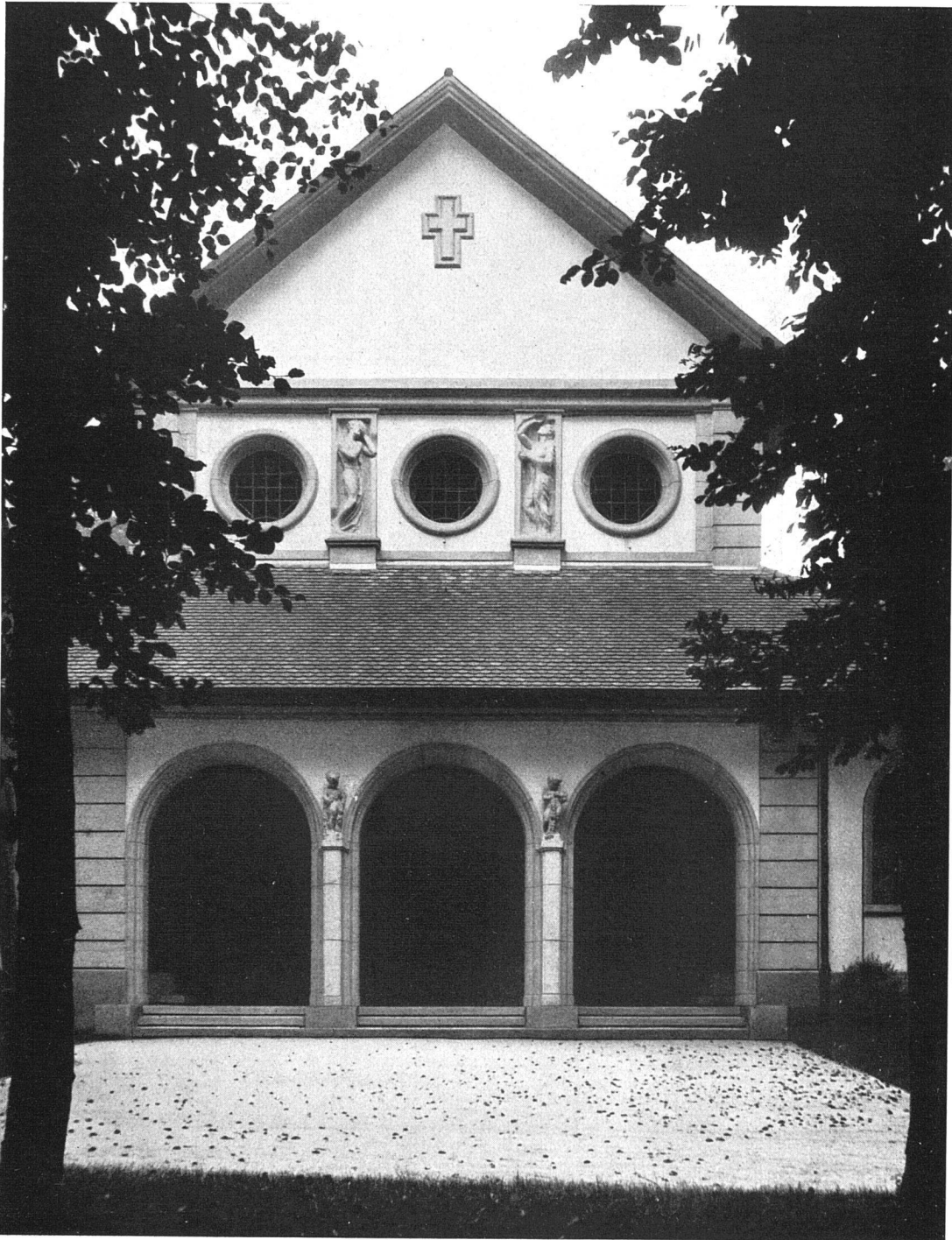
Waldfriedhof in Schaffhausen. — Eingang zur Halle. Architekt: C. Werner, Schaffhausen.
