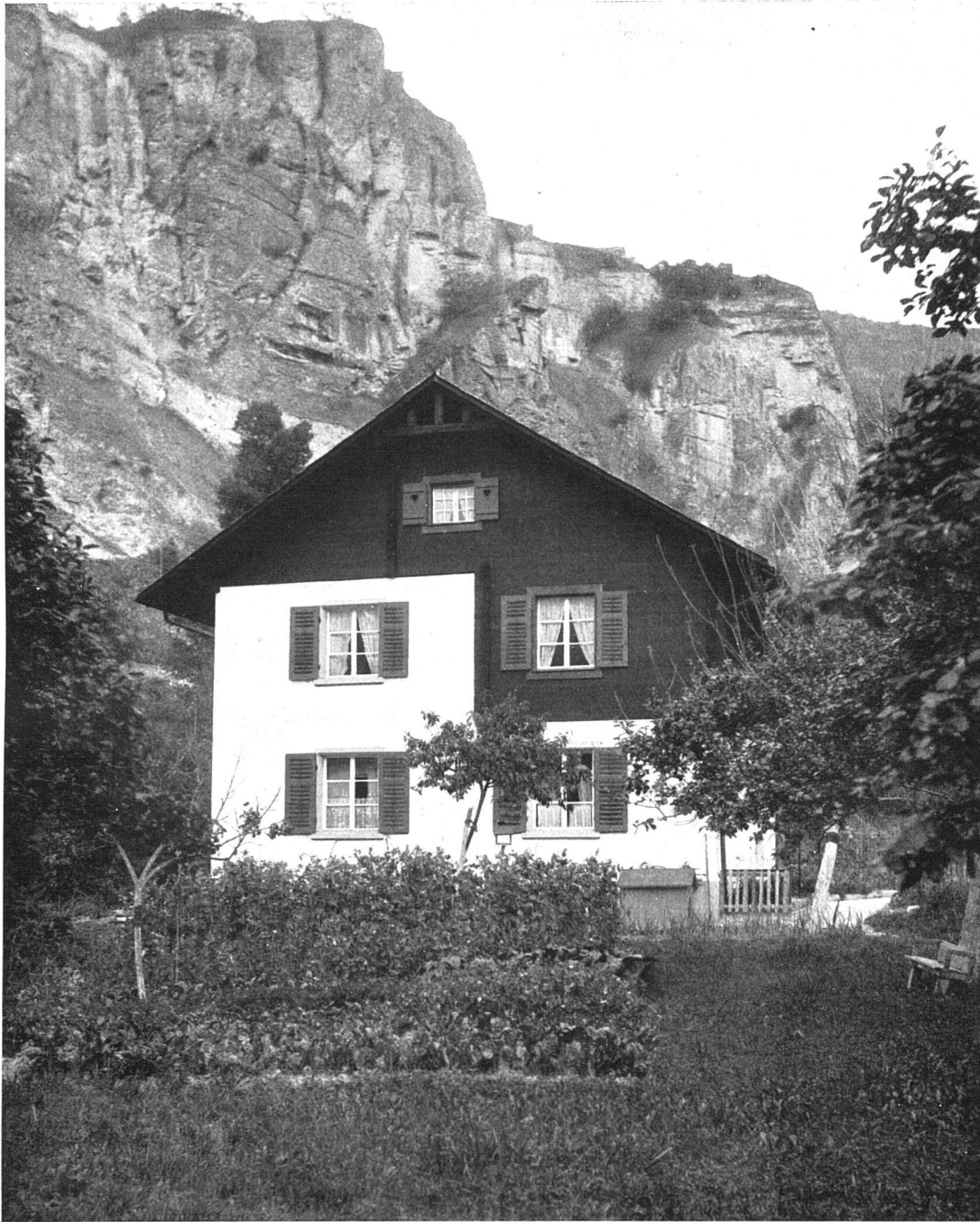
Aluminium-Industrie A.-G. Neuhausen. — Werkmeisterhaus Bramois (Nordfassade). Architekt: C. Werner, Schaffhausen.
