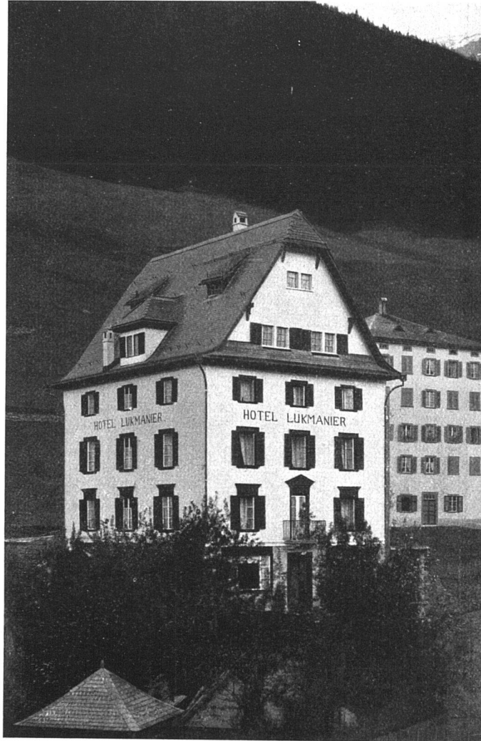
Hotel Lukmanier in Disentis (Hotelaufbau). Architekt: J. Nold, Felsberg (Graubünden).
