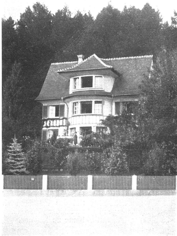
Haus an der Susenbergstrasse in Zürich. — Ansicht von der Strasse. Architekt: A. Cristofari, Zürich.
