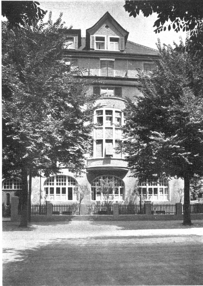
Miethausgruppe „Zum Walkerhof“ an der Hardturmstrasse in Zürich.
