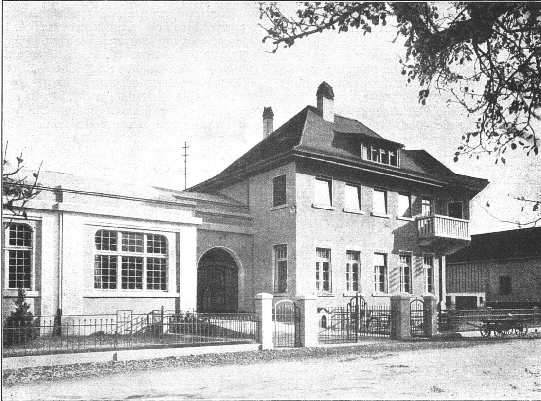
Das Wohn- und Bureaugebäude mit Fabriktor Architekt E. Hartmann, Buchs (St. Gallen); Mitarbeiter Architekt P. Müller
