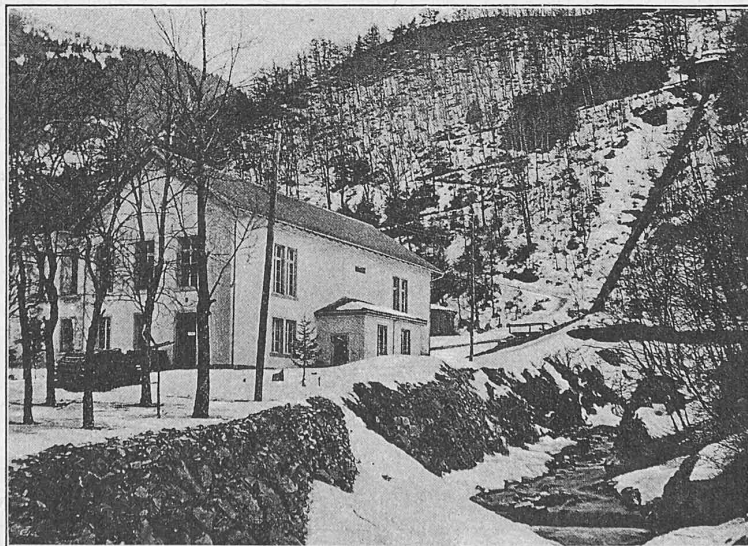
Fig. 3. Centrale des Elektrizitätswerks.
