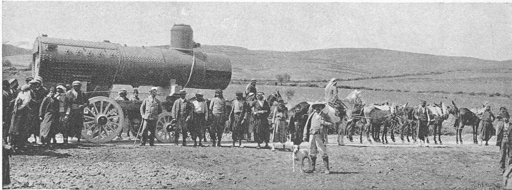
Fig. 23. Transport eines Lokomotiv-Kessels.
