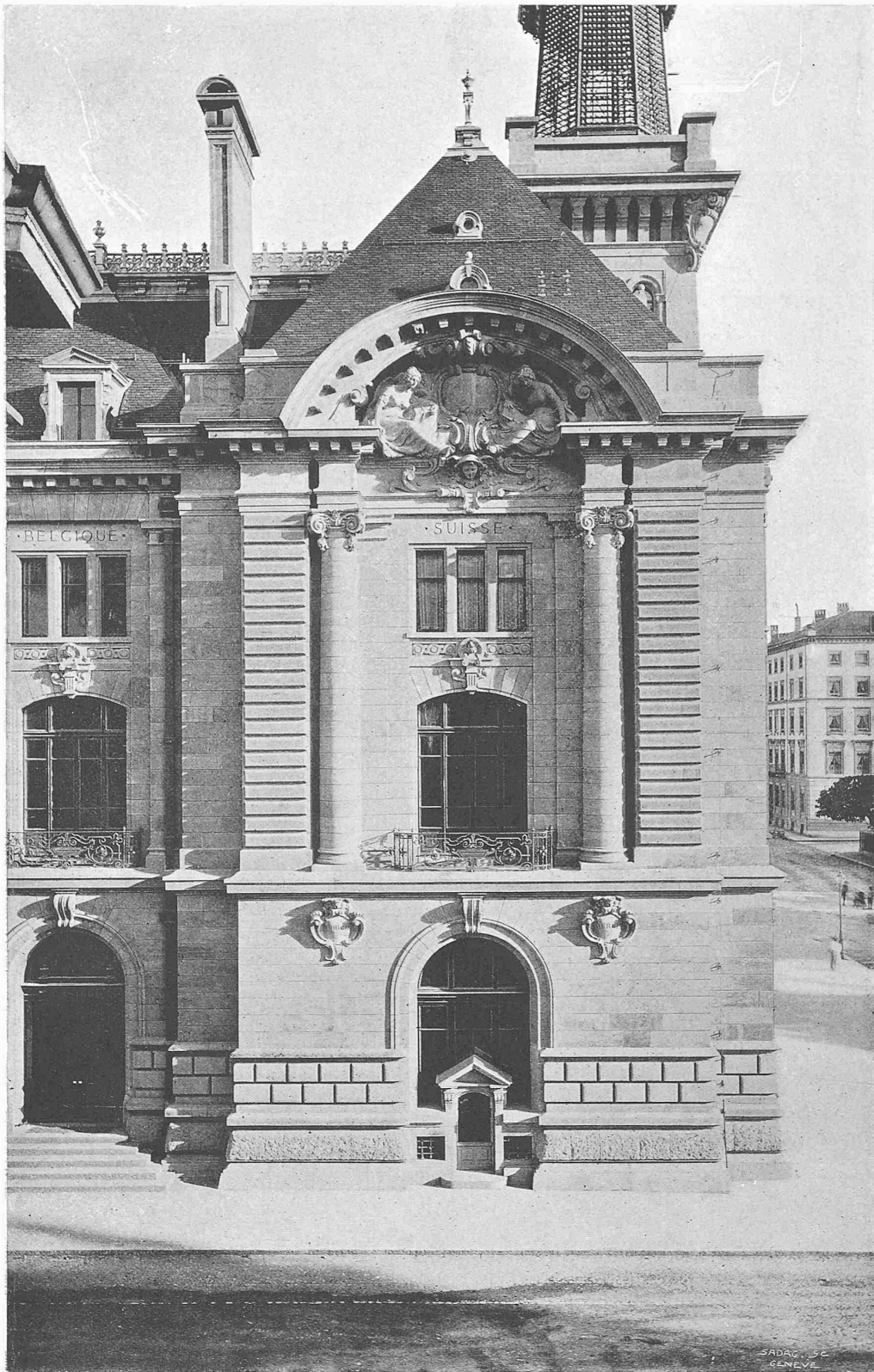
Nouvel Hôtel des Postes et Télégraphes à Neuchâtel.
