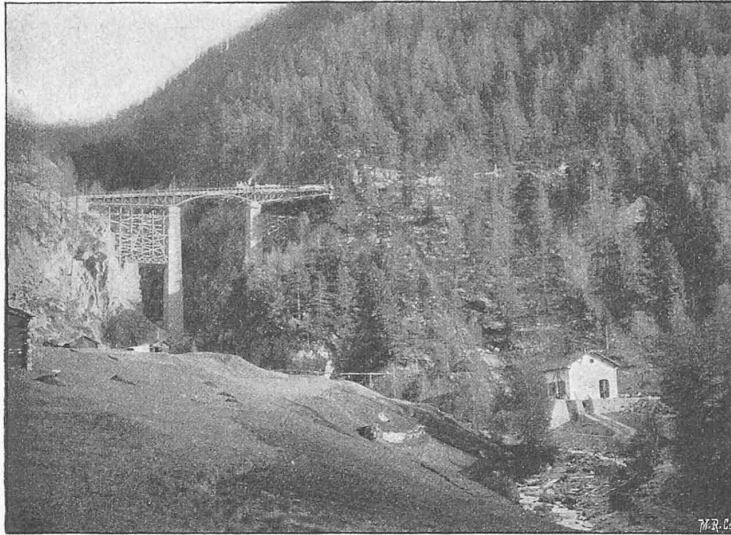
Fig. 6. Brücke über die Findelenbachschlucht. — Kraftstation.
