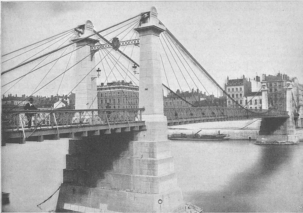
Fig. 18. Hängebrücke du Midi in Lyon.
