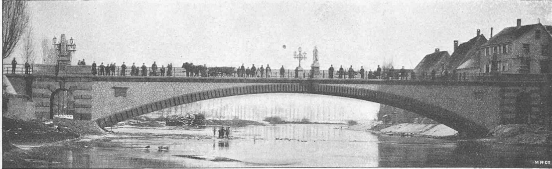
Fig. 38. Stampfbeton-Brücke über die Donau bei Munderkingen.
