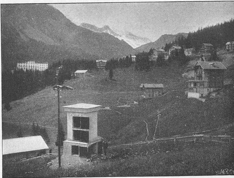
Fig. 16. Ansicht von Arosa (im Vordergrund Transformatorhäuschen).
