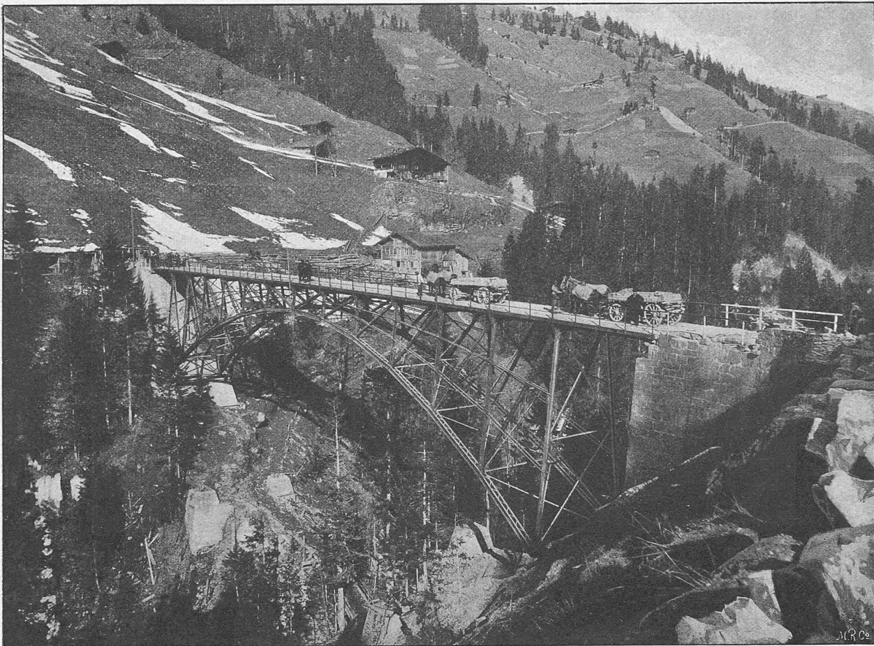
Fig. 1. Strassenbrücke über den Engstligenbach auf der Strasse von Frutigen nach Adelboden.
