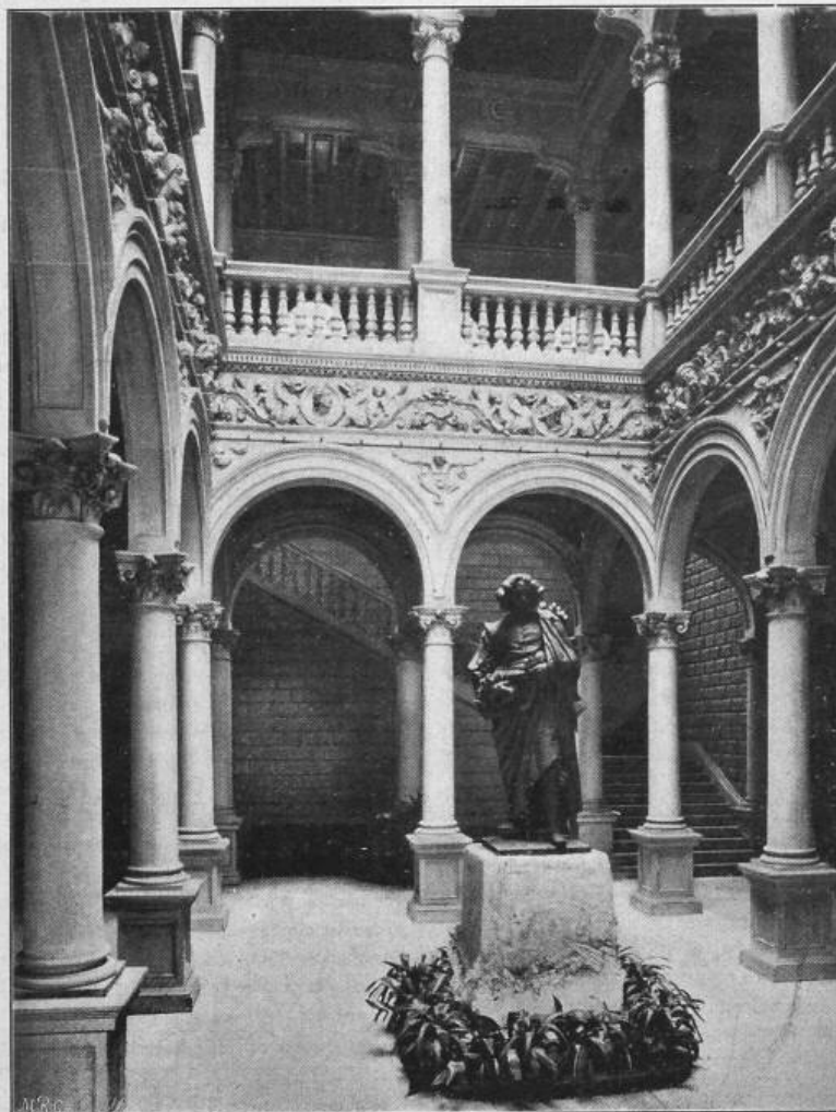
Fig. 20. Der spanische Palast. — Hofansicht. Architekt: José Urioste y Velada.
