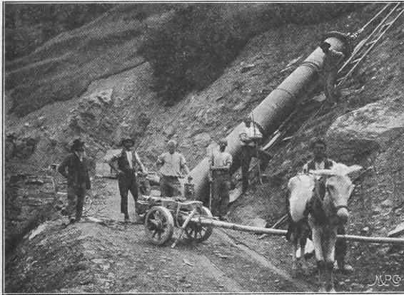
Abb. 12. Transport der Rohre.
