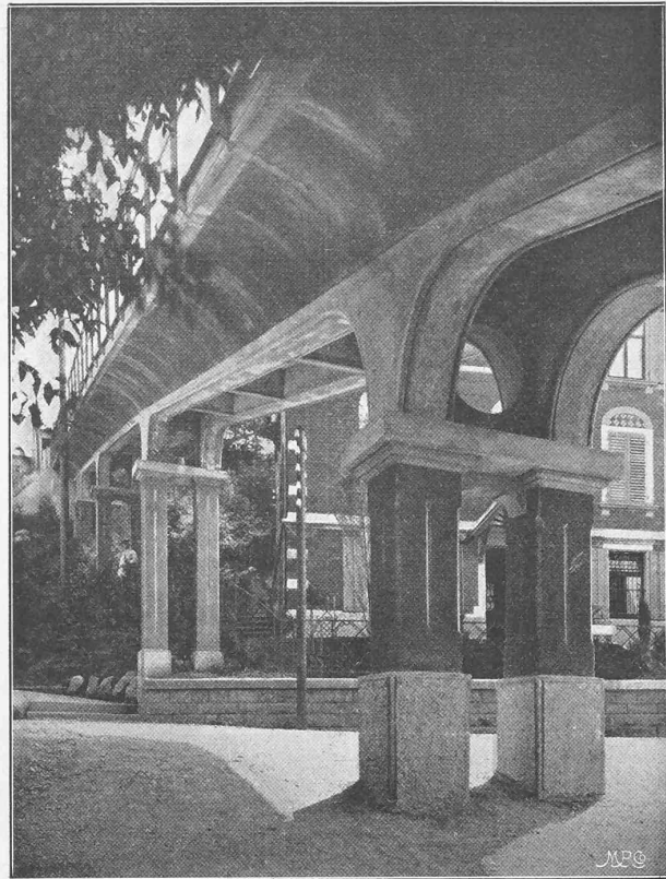
Abb. 8. Die Hadlaubbrücke. — Unterführung der Hadlaubstrasse.
