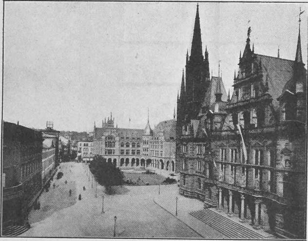
Abb. 1. Schlossplatz zu Wiesbaden. — Ansicht von Südwesten.
