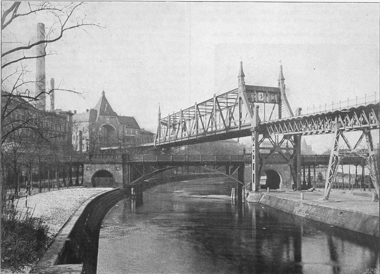
Abb. 15. Ueberbrückung des Landwehrkanals und der Anhalterbahn.
