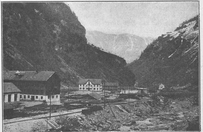
Abb. 55. Südseite. — Unterer Teil des Installationsplatzes.
