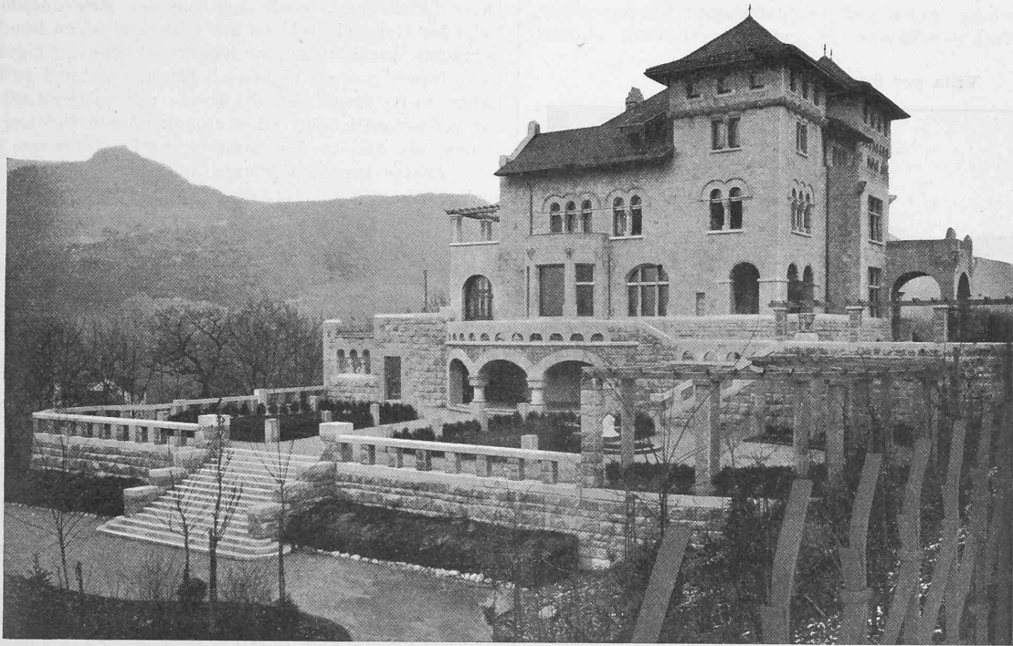
Abb. 4. Ansicht von Westen.
