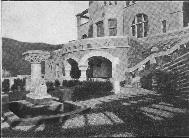
Abb. 6. Westseite; untere Terrasse mit Brunnen.
