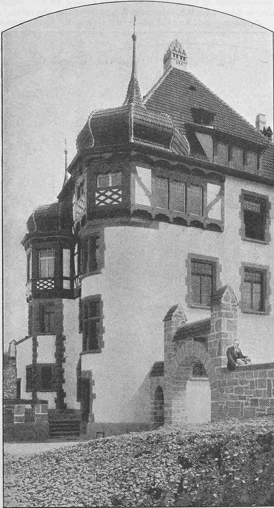
Abb. 4. Ansicht von Nordwesten.
