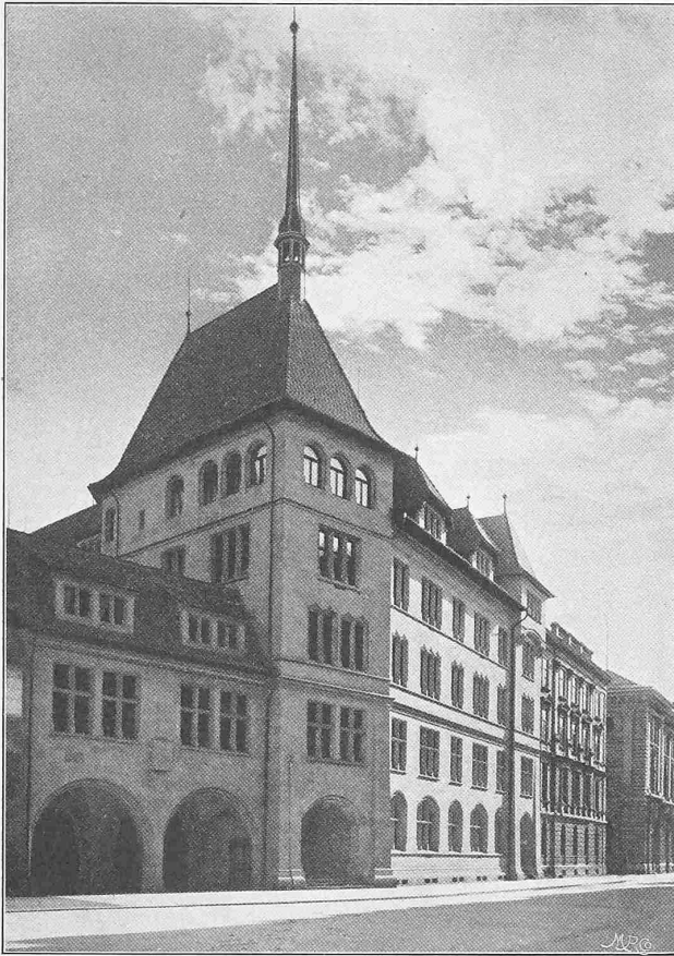
Abb. 8. Ansicht der Fassade in der Fraumünsterstrasse.
