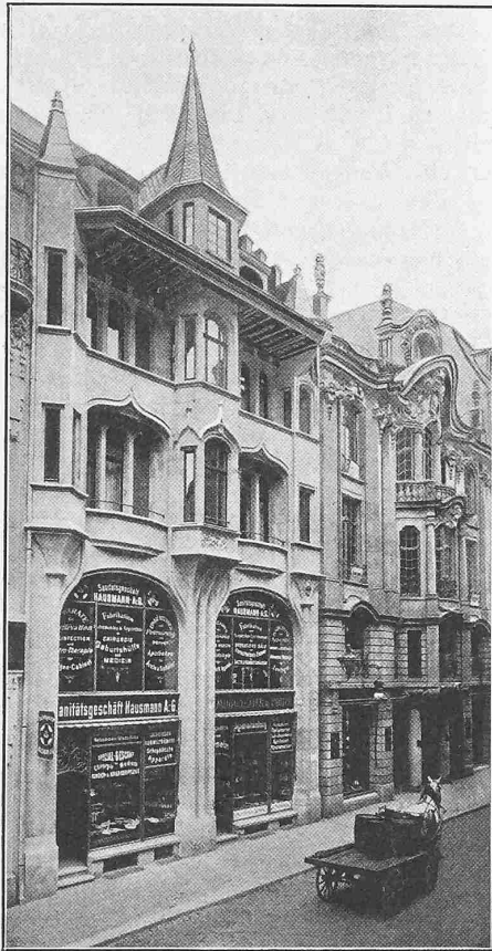
Abb. 51. Das Haus «zum Hermelin», Freie Strasse Nr. 15. Entworfen von A. Visscher van Gaasbeek, Architekt in Basel.
