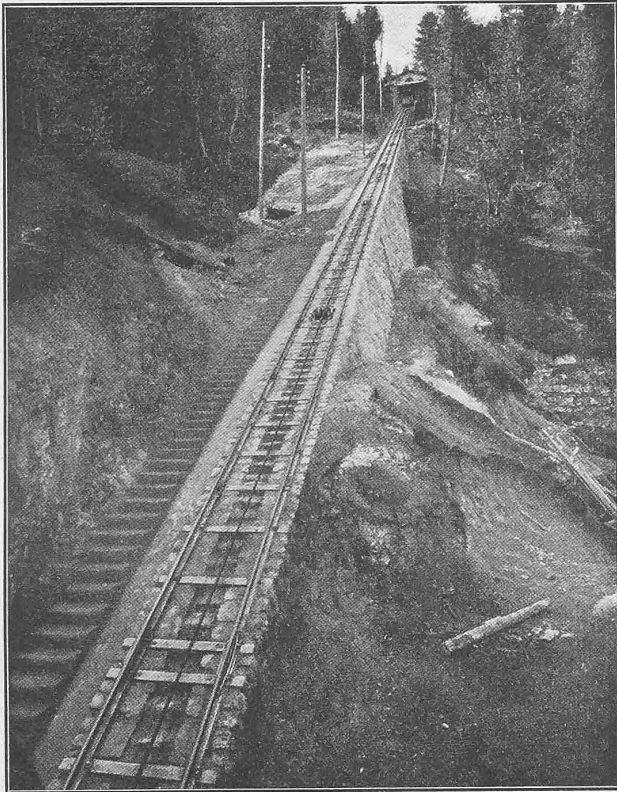
Abb. 14. Der Oberbau auf der obersten Strecke der Seilbahn.
