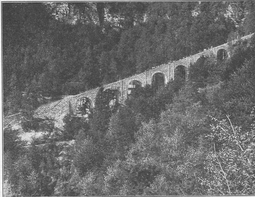
Abb. 12. Seitenansicht des grossen Viaduktes der Seilbahnstrecke.
