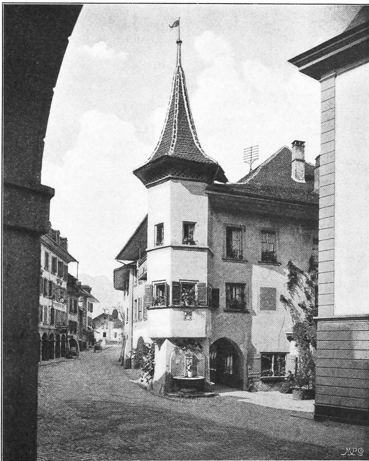
Erkerbau «zum Rosengarten» in Thun.
