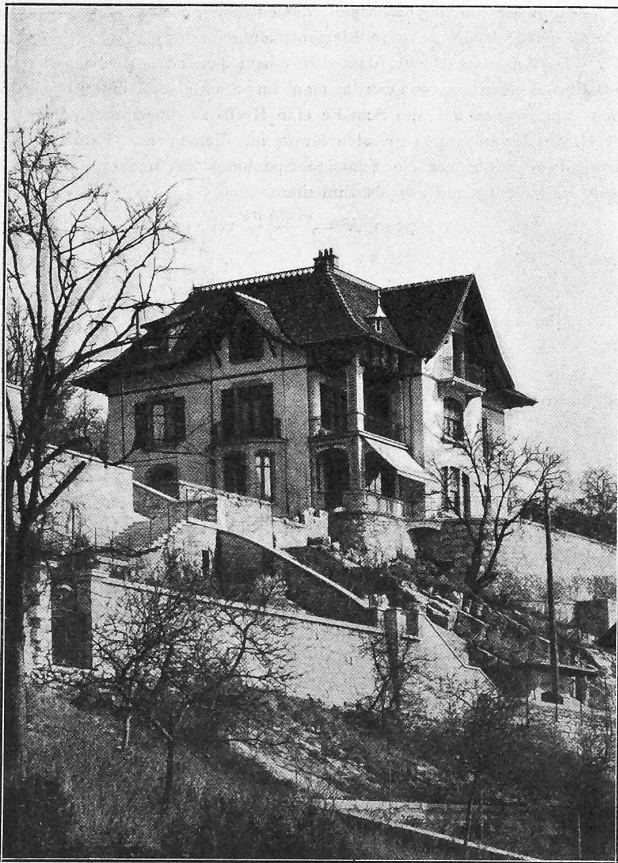
Fig. 38. Maison Chable à Neuchâtel. — Architecte M. G. Chable .
