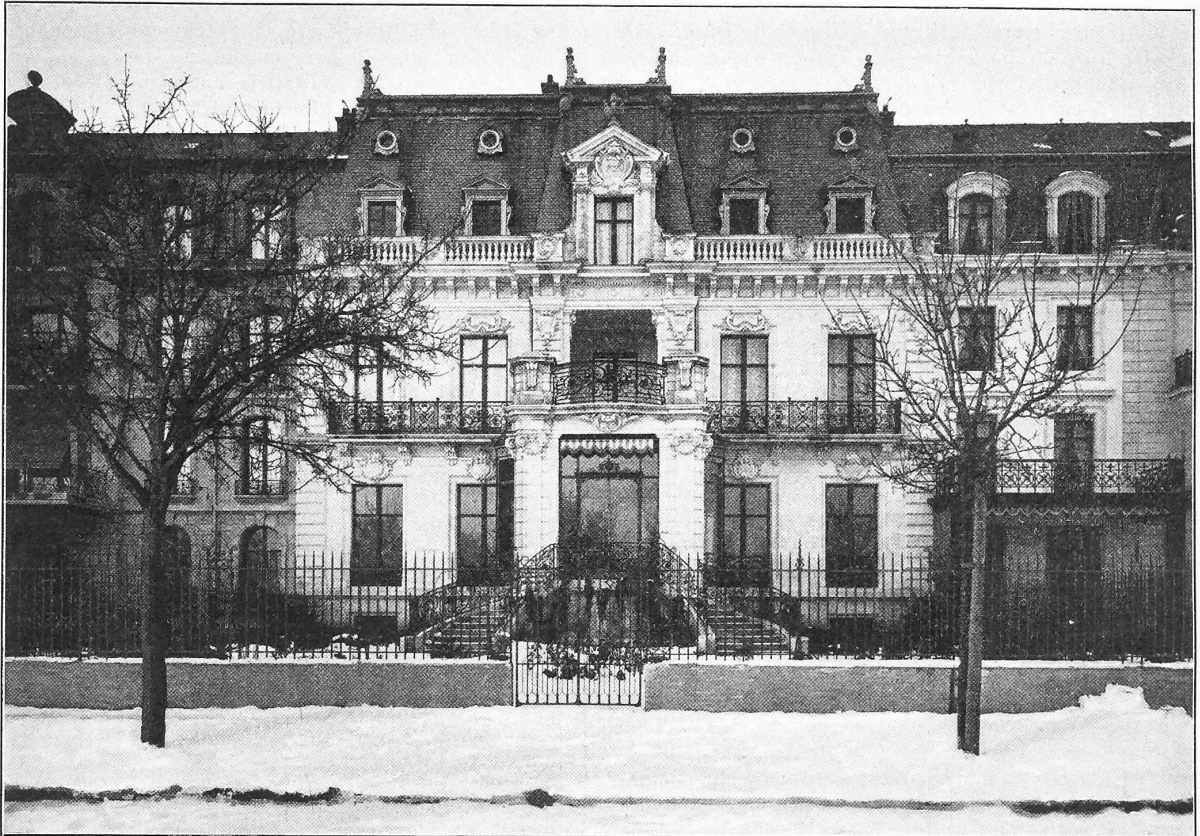
Fig. 24. Maison de Monsieur de B. à Neuchâtel. Façade sur le jardin du côté du lac. — Architecte M. Alfred Rychner.
