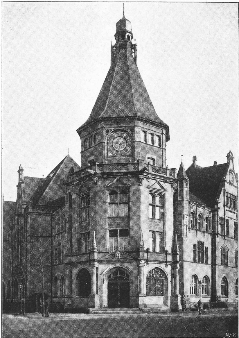
Abb. 1. Ansicht des Eckturms mit dem Haupteingang.
