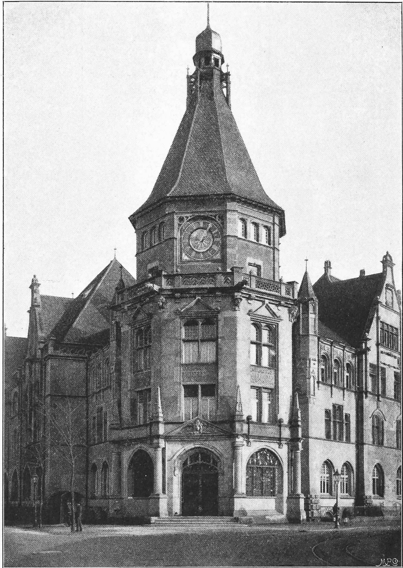
Abb. 1. Ansicht des Eckturms mit dem Haupteingang.
