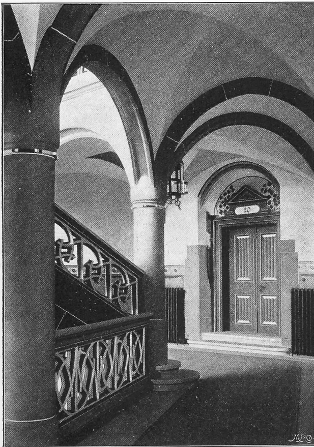
Abb. 7. Treppenaufgang im I. Stock.
