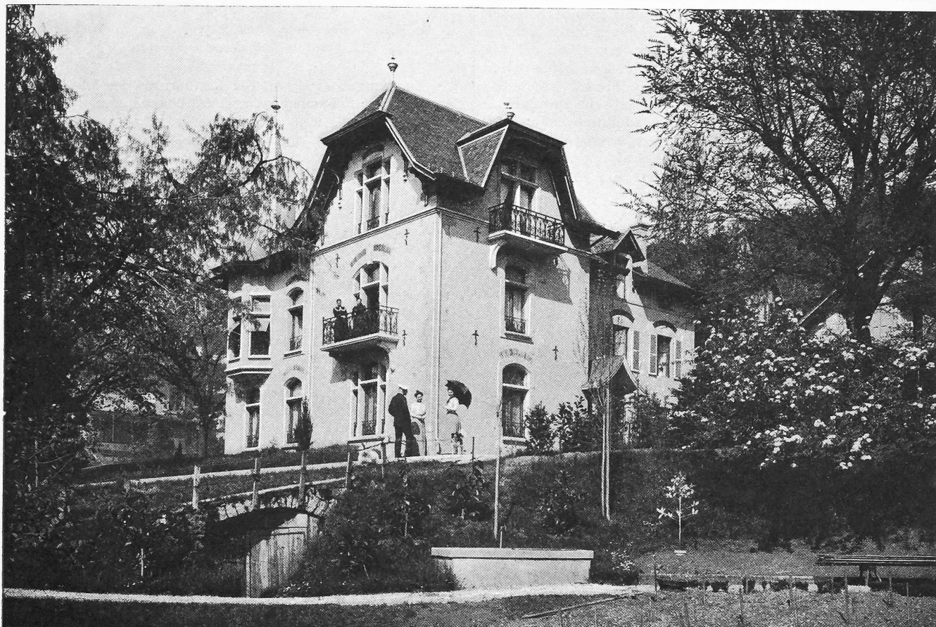
Fig. 47. Maison de Monsieur le Dr. F. — Architecte M. A. Rychner à Neuchâtel.
