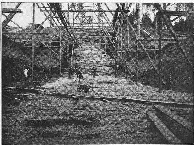
Abb. 20. Reinigung der Fundamentsohle für die östliche Staumauer.
