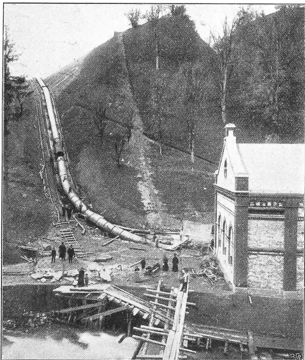
Abb. 1. Ansicht der Zentrale mit der Druckrohrleitung im Bau.
