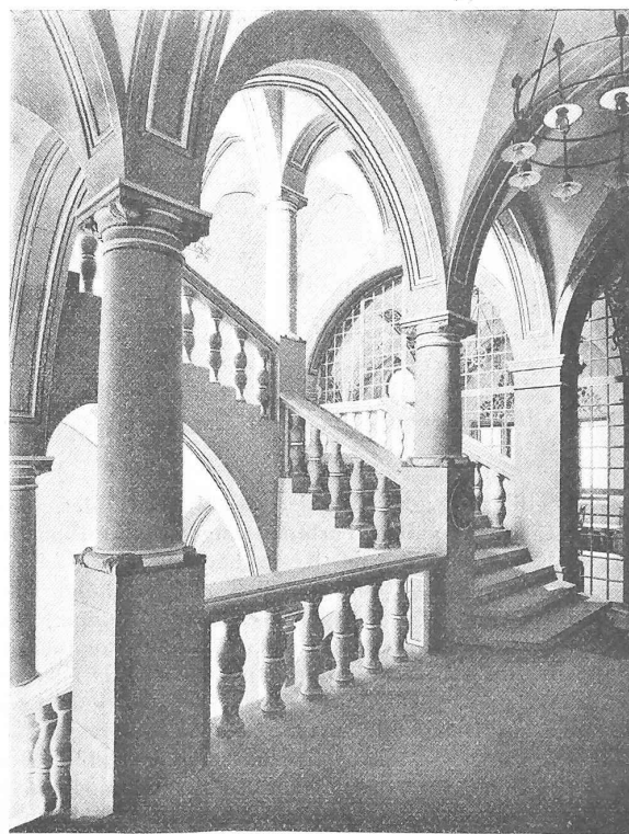
Abb. 31. Blick in das Haupttreppenhaus im I. Obergeschoss.
