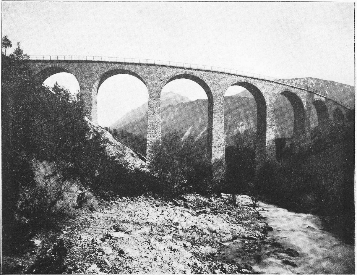
Abb. 18. Der Schmittentobel-Viadukt. — Ansicht von Norden.
