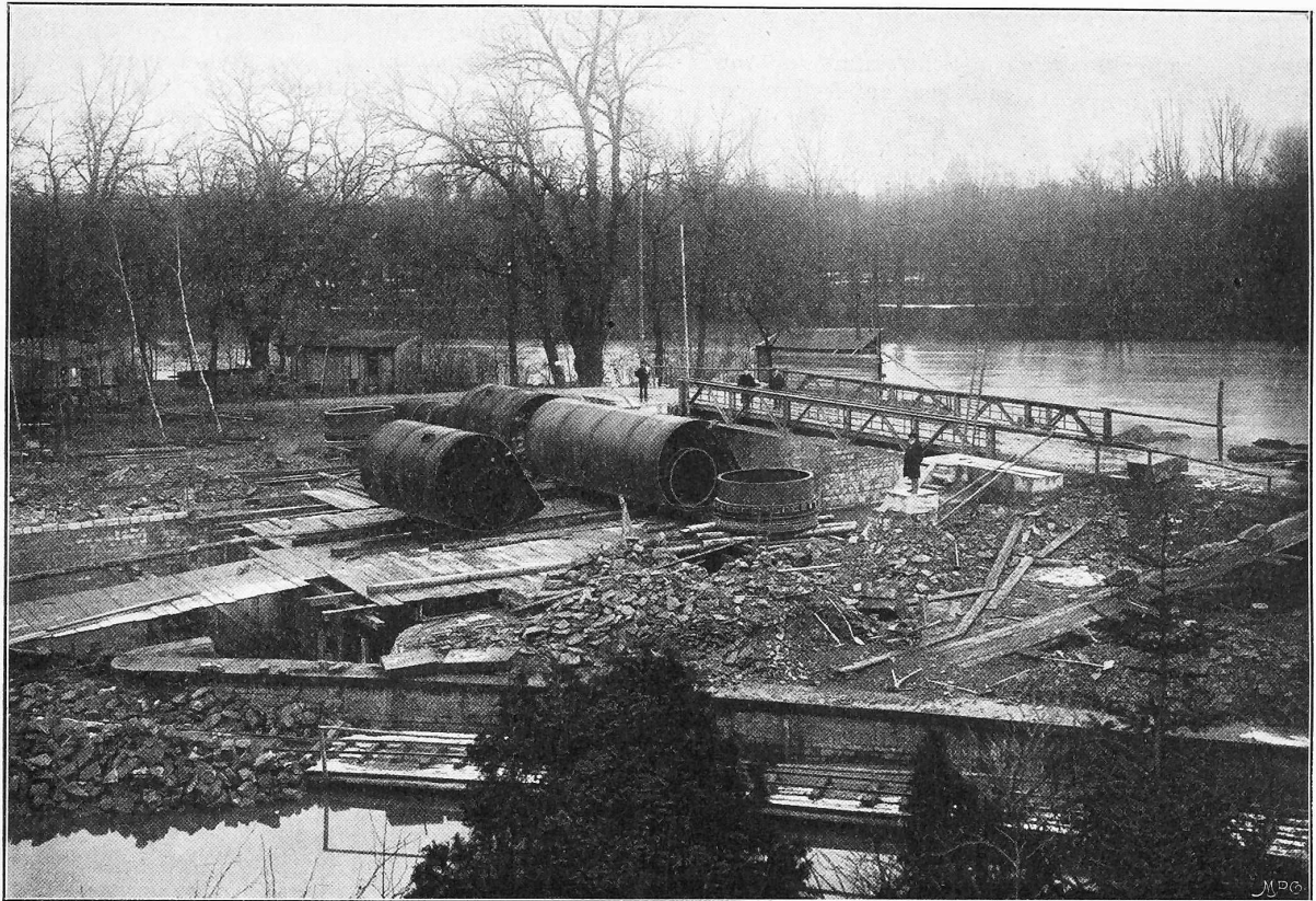
Abb. 6. Das Walzenwehr des Grundablasses bei Schweinfurt am Main während der Montage.
