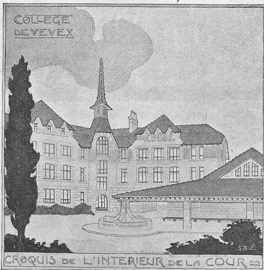
Blick in den Hof von Südwest.
