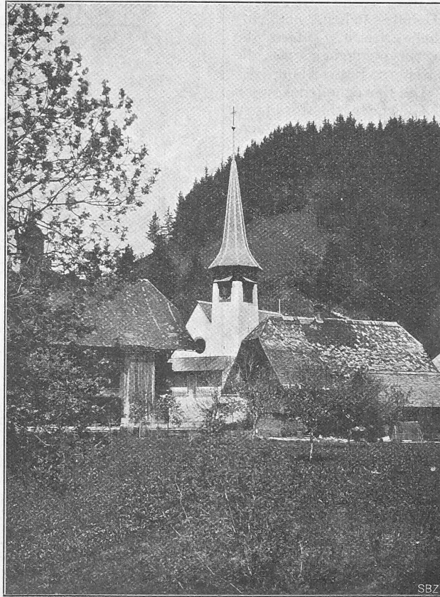
Abb. 7. Ansicht von Süd-Osten.
