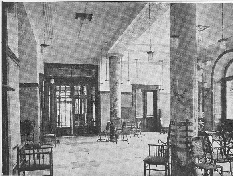
Abb. 2. Blick in die Halle.
