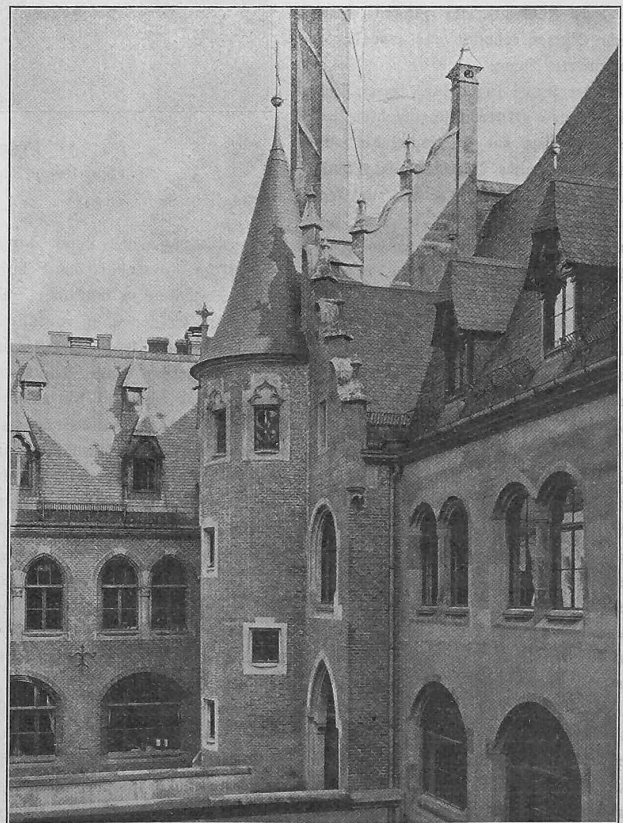
Abb. 12. Blick auf das Treppentürmchen des Kassenhofs.
