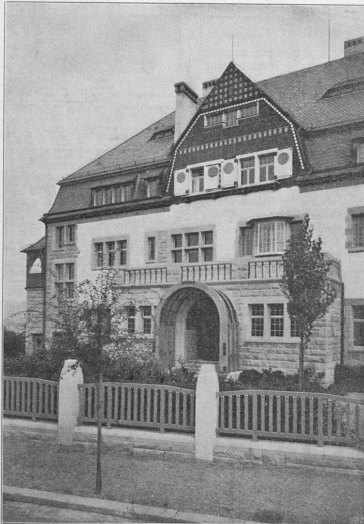
Abb. 1. Ansicht eines Teiles der Westfassade mit dem Haupteingang.
